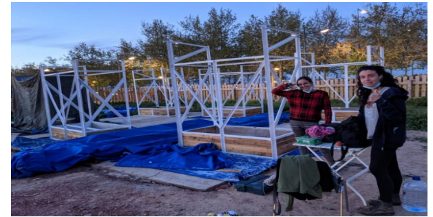
Trabajo solidario de construcción del Centre Cívic Verd
