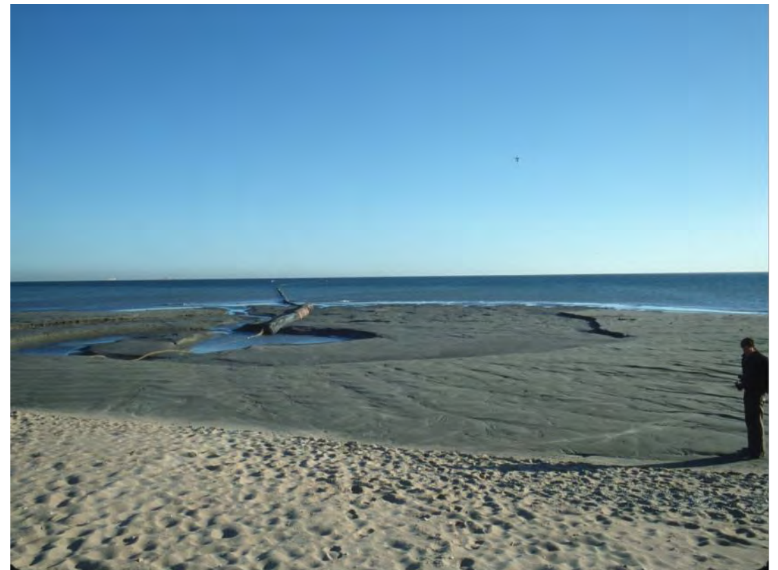
Platja dels Ferros. Any 1990. Canonada col·locada perpendicular a la platja per realitzar el transport d'arena procedent de la platja submergida situada al nord del port de València extreta amb draga. L'arena aportada era massa fina. (Foto Servei Tècnic Devesa-Albufera).
